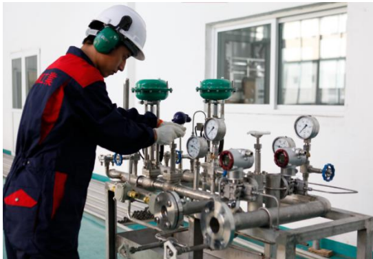
LNG bunkering station
