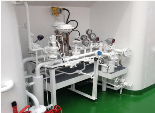
LNG bunkering station
